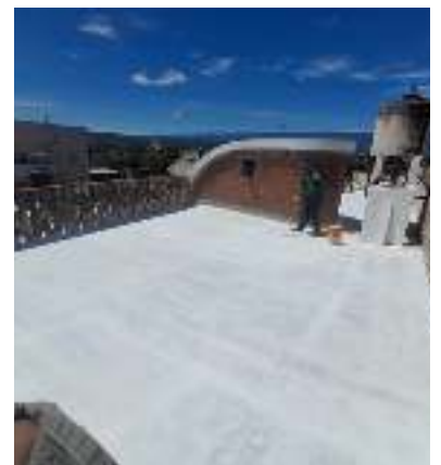
Colocación de membrana impermeable con refacciones necesarias.
